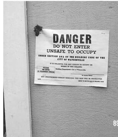
(左) 1989年10月18日(日本時間)に起こったロブリータ地震で被害を受け、余震による倒壊のおそれのある民家(米国カリフォルニア州ワトソンビル市)。(右)被害を受けた建物に表示された被災度判定結果の一例。この表示は立入禁止を示します。窪田 将氏((財)地震予知総合研究振興会)撮影・提供。
