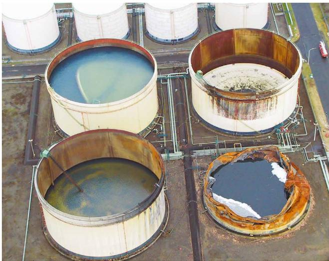
写真1 平成15年(2003年)十勝沖地震の際に苫小牧市に立地する石油タンクで発生した浮き屋根沈没被害(札幌市消防局撮影)。
