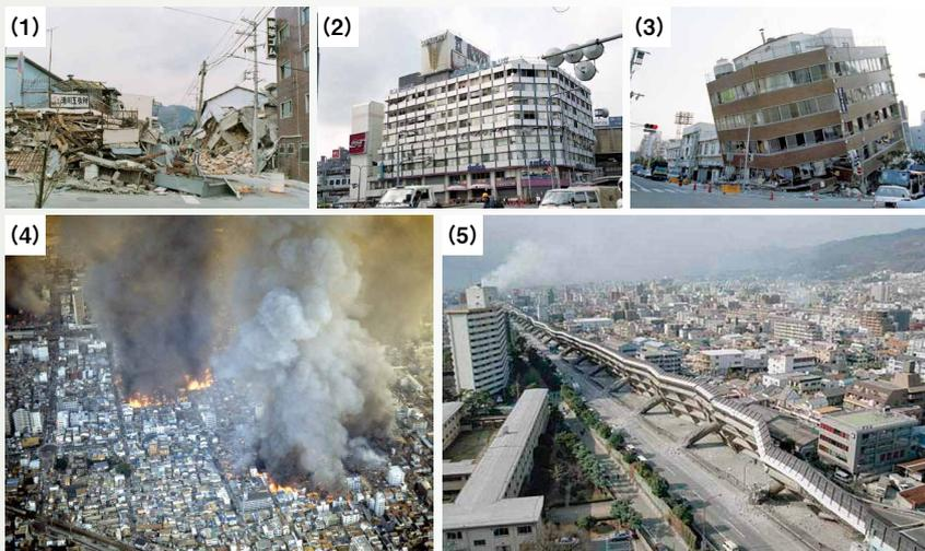
写真 (1)本山南町で全壊した木造家屋（神戸市東灘区）、(2)中間層が崩壊した神戸交通センタービル（神戸市中央区）、(3)1階の一部が崩壊して傾いた建物（神戸市中央区）、(4)御屋敷通周辺の大規模火災（神戸市長田区）（(1)～(4)写真提供：神戸市）、(5)阪神高速道路3号神戸線の倒壊（神戸市東灘区）（時事通信社 <https://www.jiji.com/news/handmade/topic/004soc/hds00101-4995608.jpg>）
