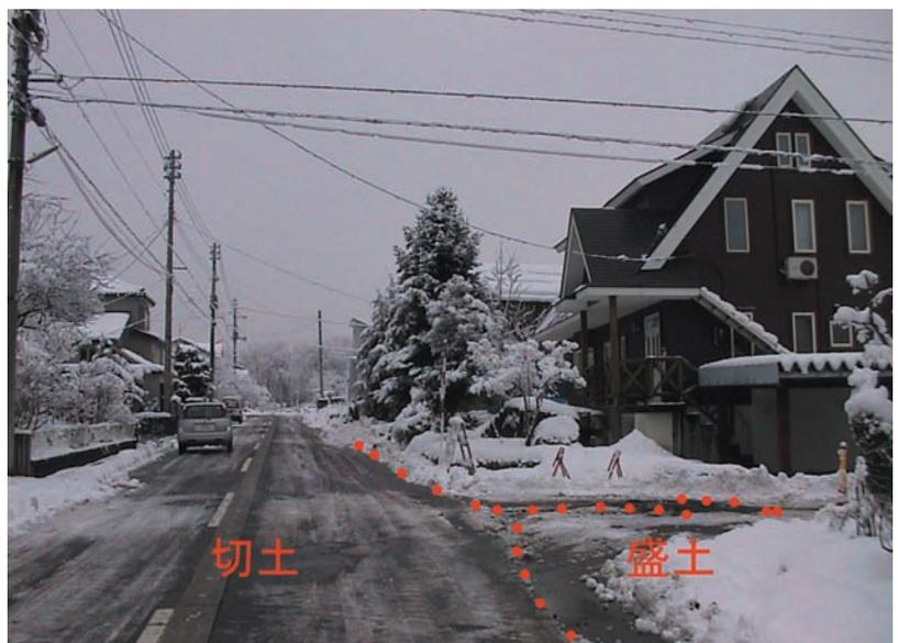
写真2 長岡市東部の丘陵地に開発された住宅地(12月31日、山口勝撮影)。道路に沿って切盛境界があり、右側が谷側の盛土地。路上面には50cm以上開いた亀裂もある(赤点線)。新しく建てられた家にも赤い危険宅地の判定結果が張られていた。雪国仕様で鉄筋コンクリートの丈夫な基礎の上に、積雪に耐えるように作られた住宅が多い中越地域では、地震動そのものによる被害より、地盤災害による被害が目立った。
