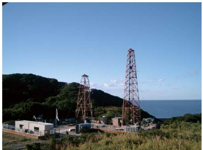
図5 新規地下水等総合観測点の室戸市 (N8) における工事風景 (2007年11月撮影)。右側の大きい檣(やぐら)で孔1を、左側の小さい檣で孔2の掘削をしています。現在は、地表部には観測小屋があるだけです。
