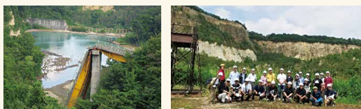
写真 (左) 災害遺構として残る旧・祭時大橋の姿 (右) 崩落崖を臨む地すべり移動体上にて
